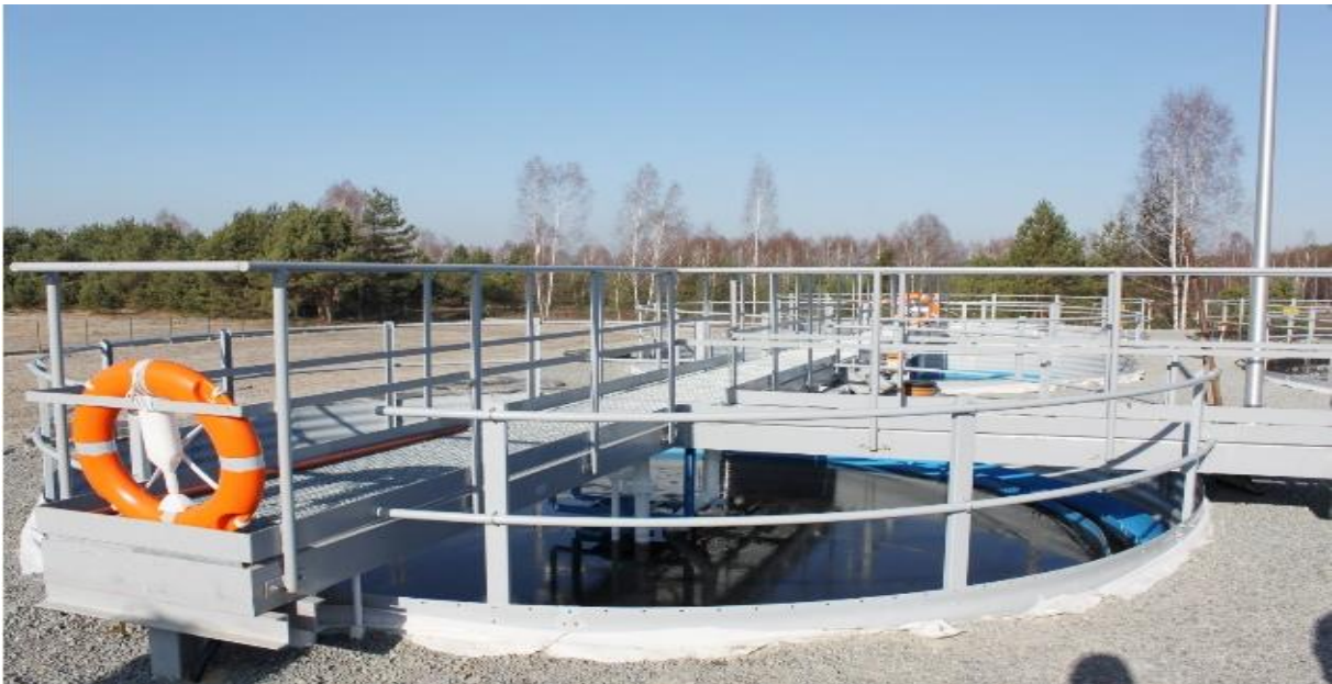
Zdj.4. Oczyszczalnia ścieków w Radomyślu nad Sanem [3]
