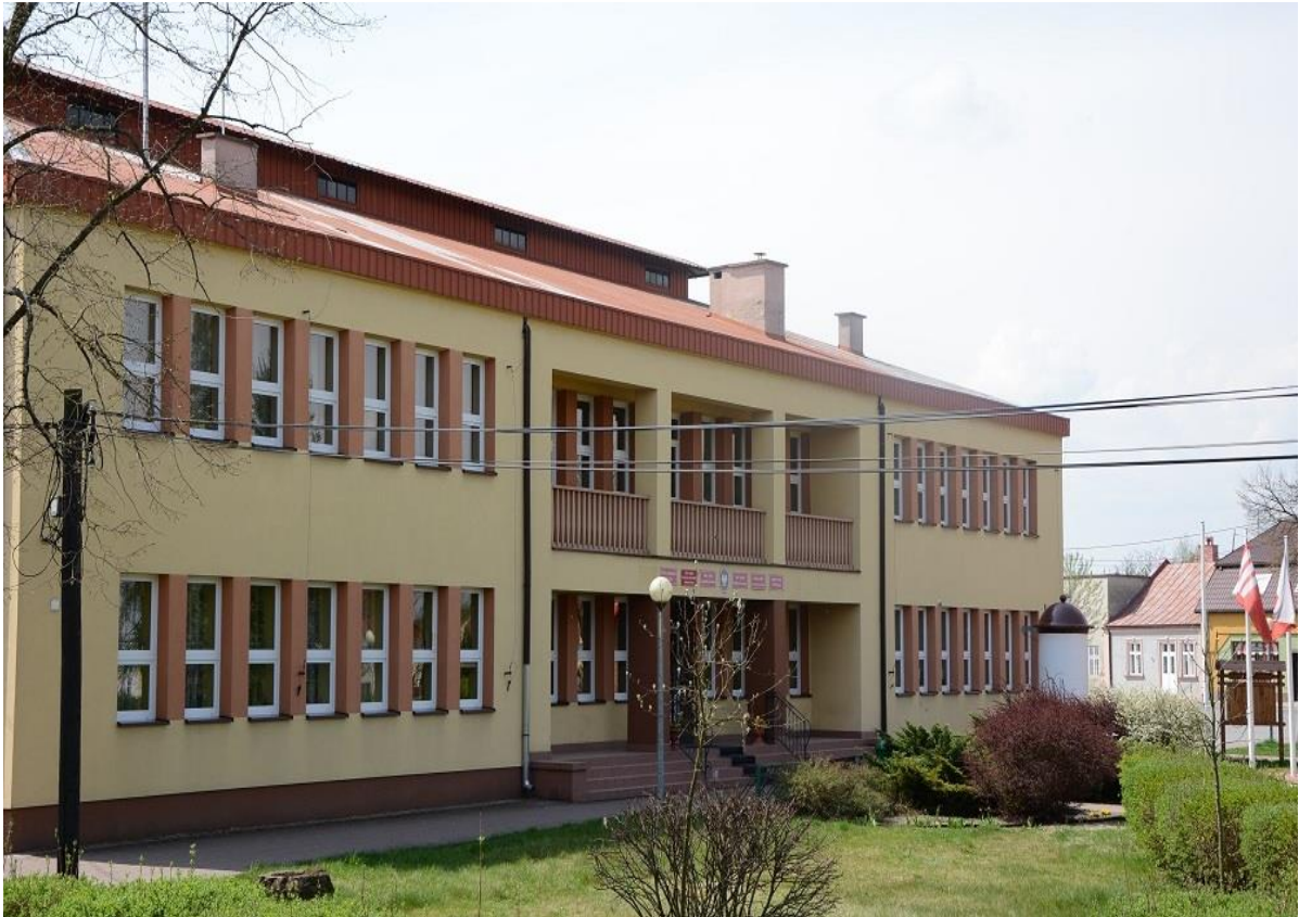
Zdj.9. Budynek Urzędu Gminy w Radomyślu nad Sanem
