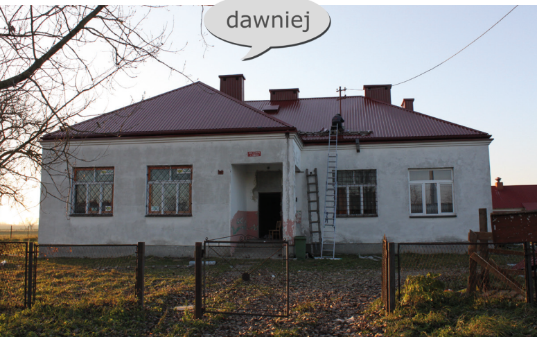
Dom Ludowy w Dąbrówce Pniowskiej (przed remontem)
