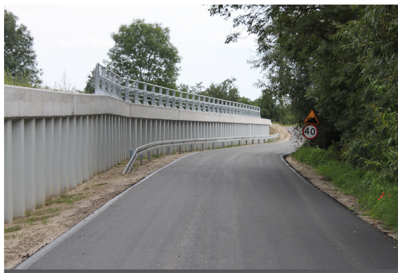
Zmodernizowany odcinek drogi Nowiny - Czekaj Pniowski
