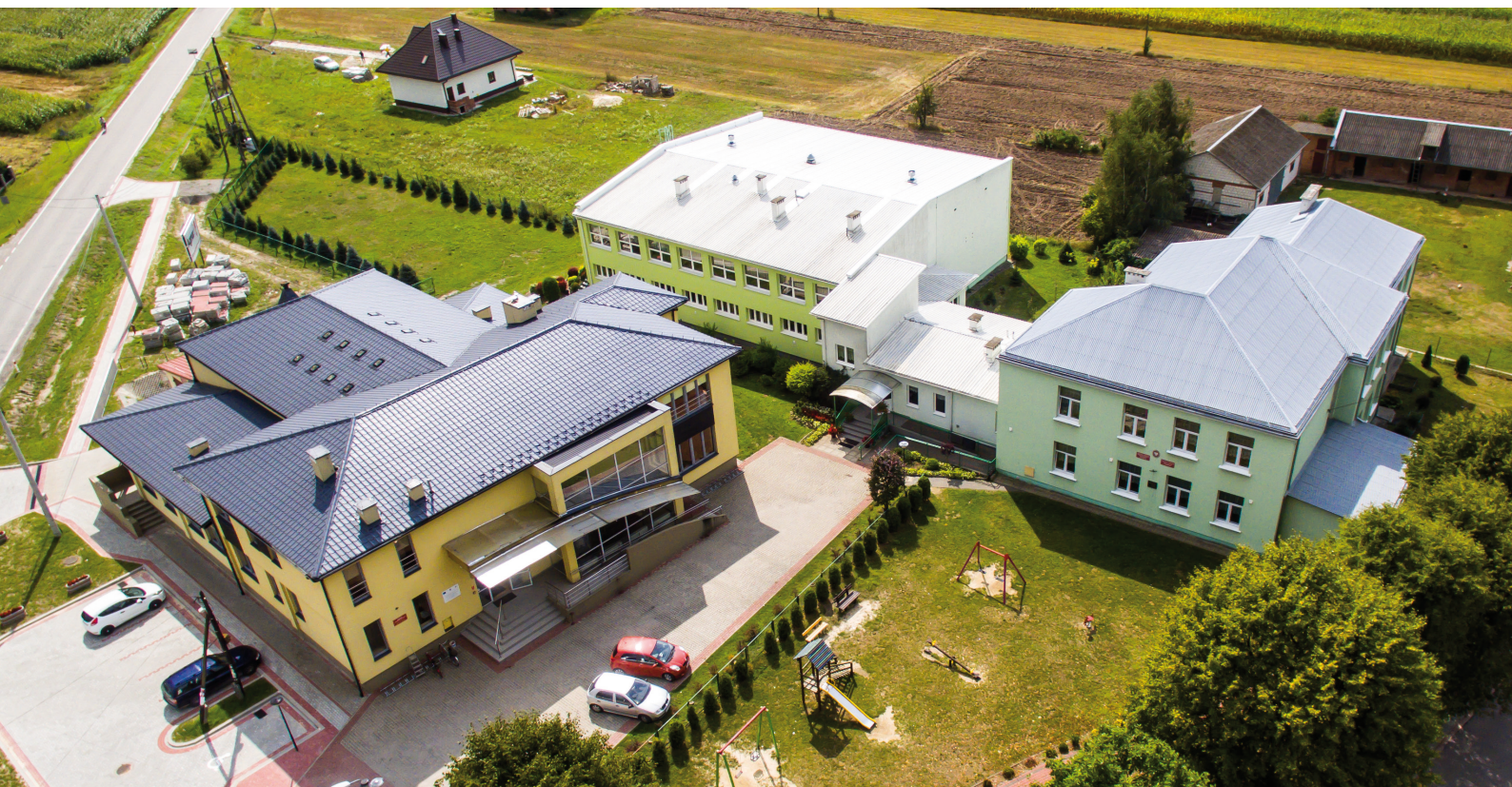
Sala gimnastyczna przy szkole w Chwałowicach - obok Wiejski Dom Kultury
