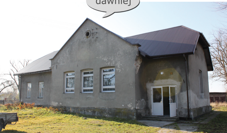
Dom Ludowy w Woli Rzeczyckiej (przed remontem)
