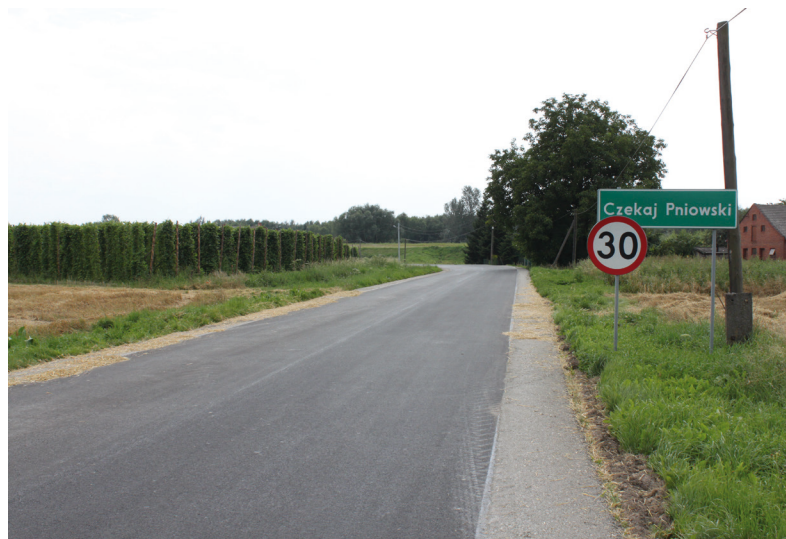
Zmodernizowany odcinek drogi do przeprawy promowej
