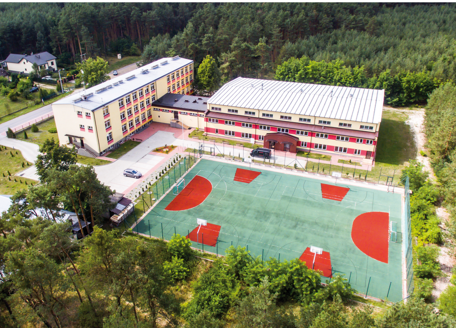
Hala sportowa przy szkole w Radomyślu nad Sanem
