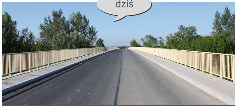
Przebudowany most na rzece San w Radomyślu
