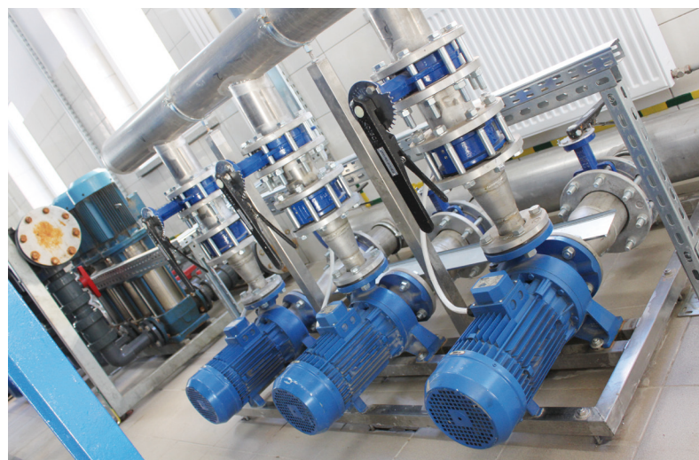
SUW w Radomyślu nad Sanem po przebudowie
