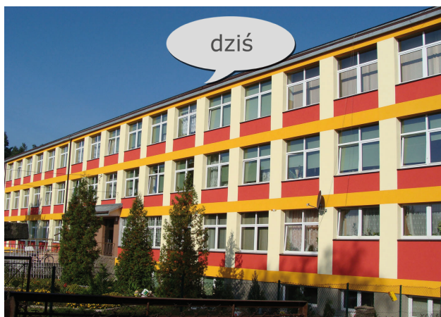
Szkoła w Radomyślu po termomodernizacji
