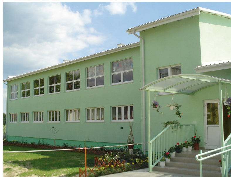
Sala gimnastyczna w Chwałowicach
