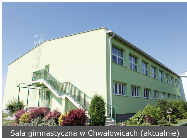
Sala gimnastyczna w Chwałowicach
